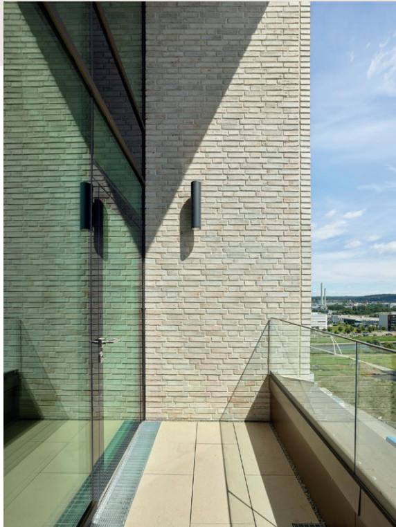
HOCHPUNKT AM FLUGFELDKLINIKUM BÖBLINGEN-SINDELFINGEN FOTO RH 016
