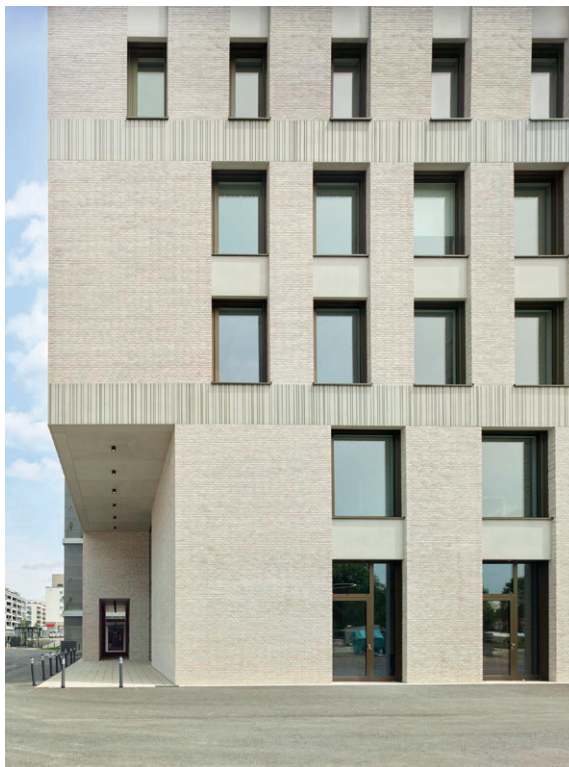
HOCHPUNKT AM FLUGFELDKLINIKUM BÖBLINGEN-SINDELFINGEN FOTO RH 38
