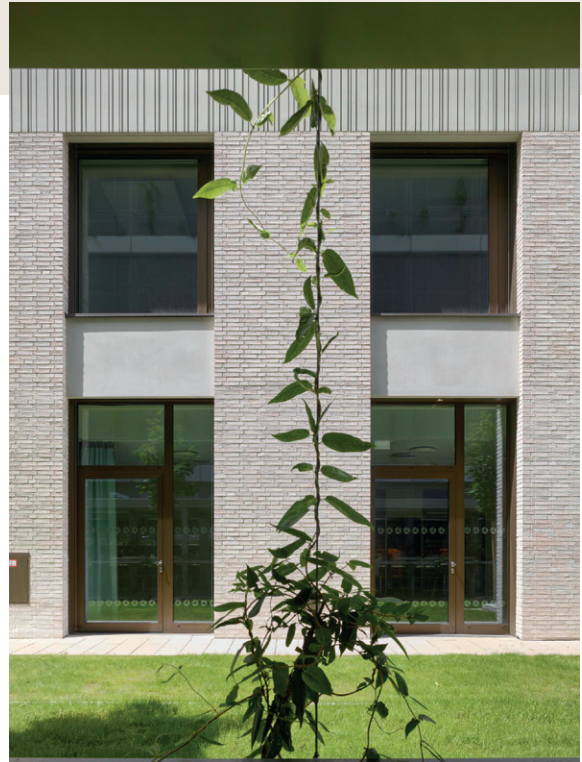
HOCHPUNKT AM FLUGFELDKLINIKUM BÖBLINGEN-SINDELFINGEN FOTO RH 24
