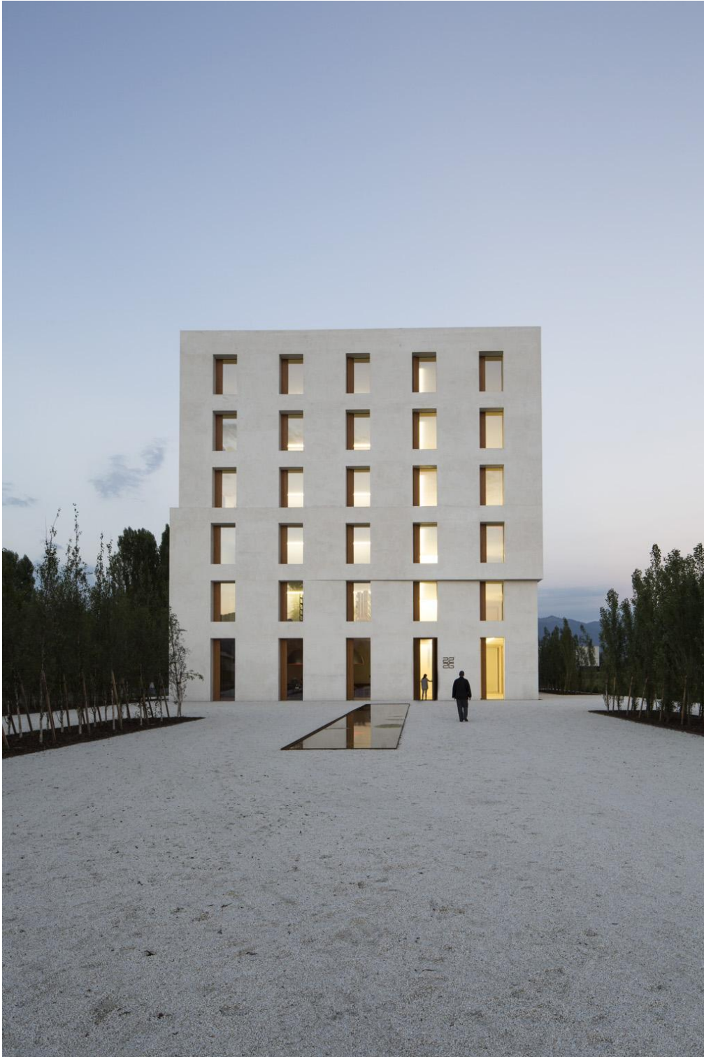
Bürohaus Baumschlager Eberle Lustenau
